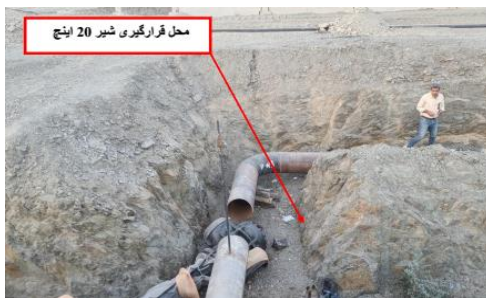
محل قرارگیری و نحوه واژگونی شیر ۲۰ اینچ بر روی فرد
