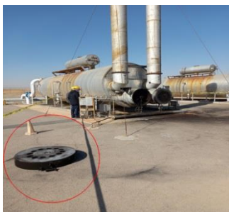
محل افتادن درب هیتر در اثر انفجار
