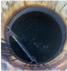
دریچه محل ورود افراد به مخزن روی سقف شناور
