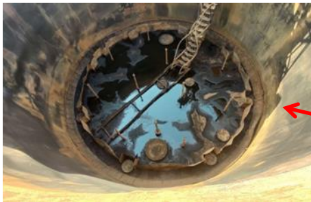
شکل ۳- وضعیت سقف شناور پس از آتش سوزی
