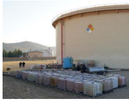
تجهیزات لایروبی به روش بسته مستقر در محل مخزن
