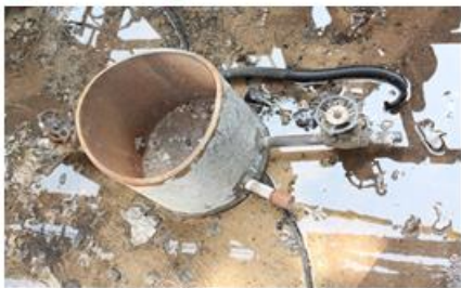
BOX-12" تهیه شده جهت نصب در محل نشت MDEA در خط 32"
