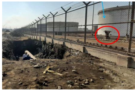
شکل ۱- نصب ترانس در فاصله ۱۰ متری خط
