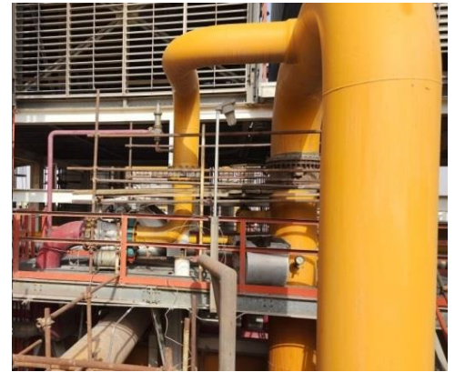
شیر کنترل فشار بالای ظرف رفلاکس
