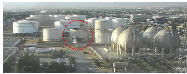
شکل ۱- بروز نشستی اولیه در مخزن
